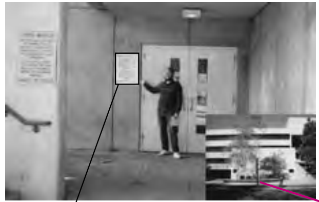
活断層直上に位置するロサンゼルス南西カレッジの校舎の入口には、「Enter this building at your own risk」との警告文が掲示されている。
