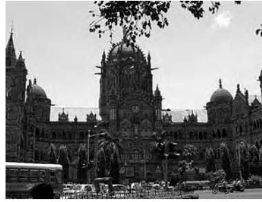
イギリス統治時代に建てられた駅舎
