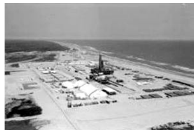
掘削基地全景
