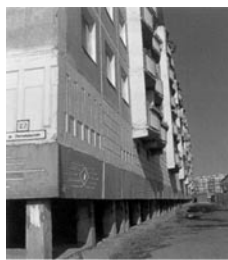
▲⑤高床になっている建物
