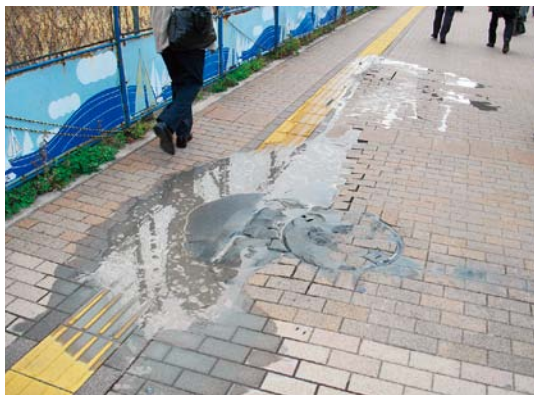
写真2 足元の歩道から砂が噴出し液状化の跡があちこちにみられた。
