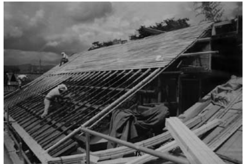
反り屋根の建築
