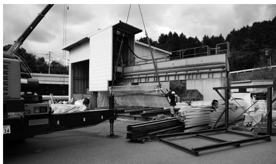
巨大なクレーンで製品を運ぶ
