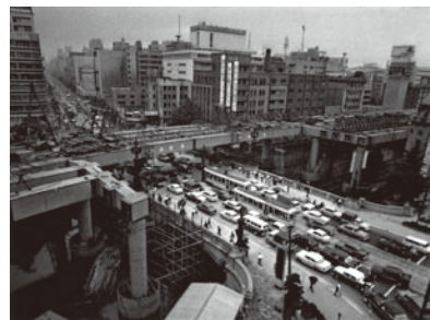
資料8 日本橋の上にかかる高速道路(1963年)
