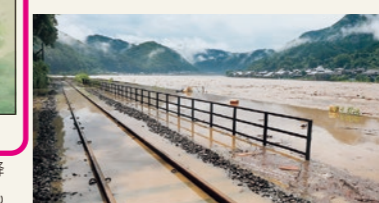
↑5 球磨川の氾濫により冠水した線路と道路(熊本県八代市、2020年7月4日)
