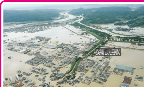
↑4 外水氾濫によって浸水した市街地(岡山県倉敷市、2018年7月) 真備地区では、大雨により堤防8か所が決壊し、海川が氾濫した(→p.207)。
