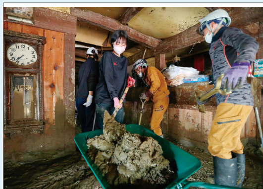
↑4 高校生ボランティア (2020年 熊本県人吉市) 豪雨で浸水被害を受けた旅館の片づけを行っている。
